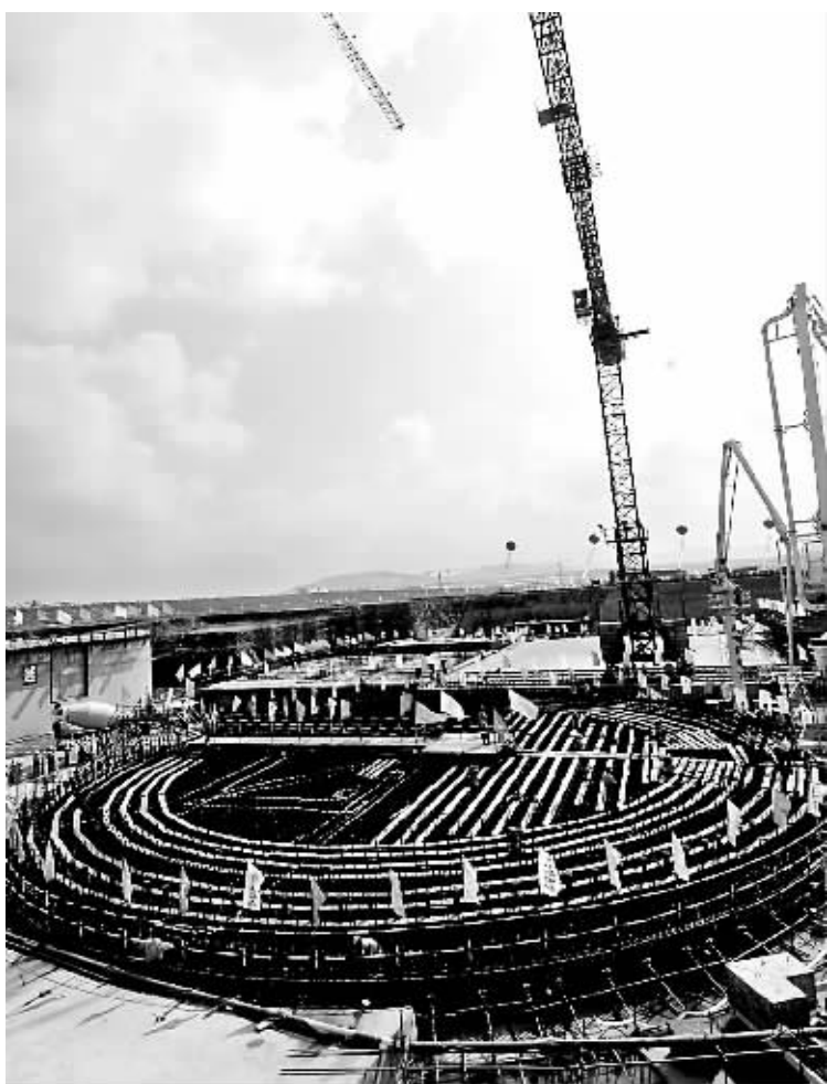
图为建设中的辽宁红沿河核电站一号机组核岛。 新华社记者 任勇/摄
