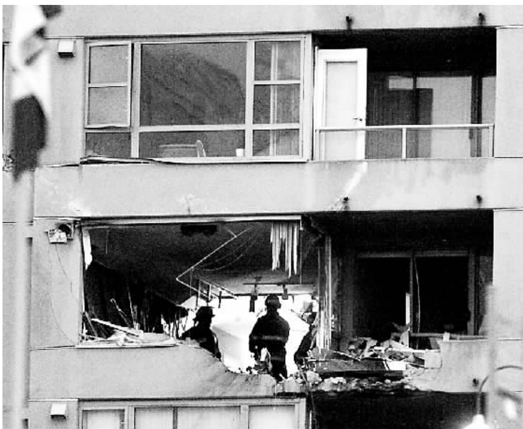
10月19日，在加拿大温哥华，消防人员在被飞机撞上的大楼内察看。当天下午，一架小型飞机从温哥华国际机场起飞，不久后撞上了附近一座15层公寓楼第九层的一个阳台，造成飞机驾驶员死亡，公寓楼内2人受伤。
