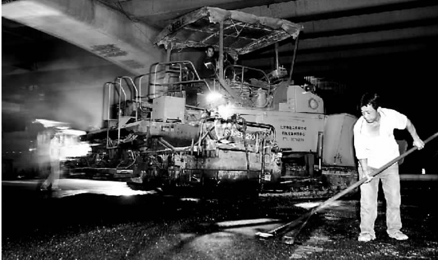
今天凌晨,随着最后一辆沥青混凝土车撤离,阜石路城市快速高架路所有路面铺油全部完成。改造后的阜石路为双向6车道,每个方向的3条车道中,有一条为公交专用道,将于奥运会前竣工通车。阜石路将与莲花池东路及长安街西延路共同构成北京西部地区与市区联系的3条交通走廊。
