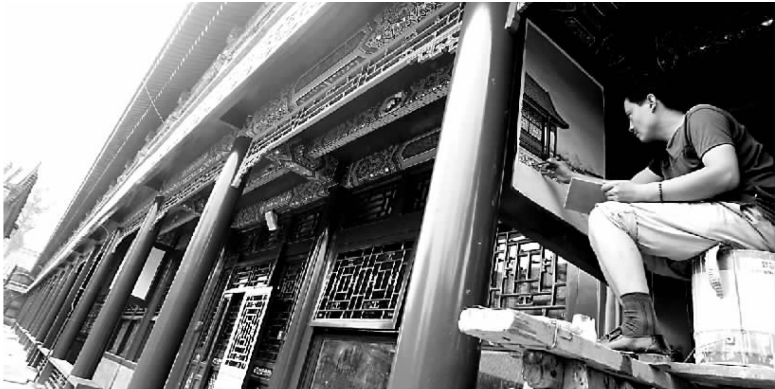
记者昨天看到,施工人员在一笔笔地为恭王府邸重绘壁画。
